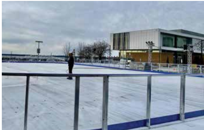
Travaux d'aménagement de la patinoire réfrigérée dans le stationnement adjacent au pavillon Robert-Middlemiss, à la marina d'Aylmer. L'ouverture officielle est prévue le 14 novembre.
